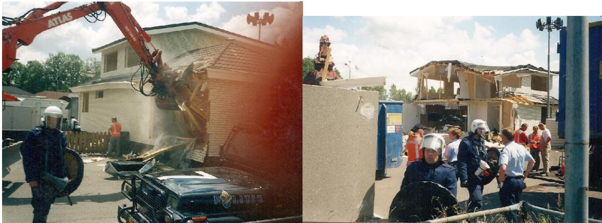
De sloop van een woonwagen in juni 1999 op het woonwagencentrum Trekvaartplein in Leiden.
