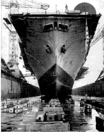
Verbouwing van het vliegtuigkampschip Minas Gerais op de werf in Rotterdam.
